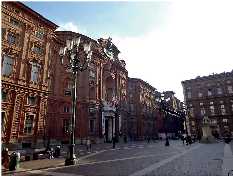
Ryc. 3. Piazza Carignano , przykład ceglanej architektury Guariniego i organizacji przestrzennej placów. Po lewej pałac Carignano , po prawej Collegio dei Nobili , w głębi kościół św. Filipa Neri. [źródło: zdjęcie autora]
